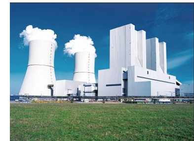
Lippendorf 2012: 10.5 Mt CO 2 (50% Vattenfall)
